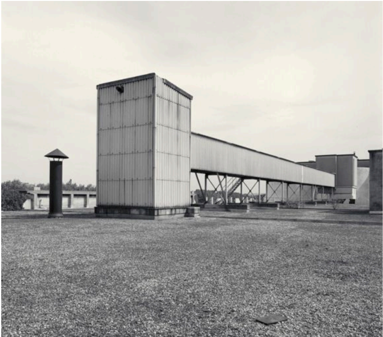
La galerie de liaison aérienne entre les silos et les ateliers depuis l'ouest
