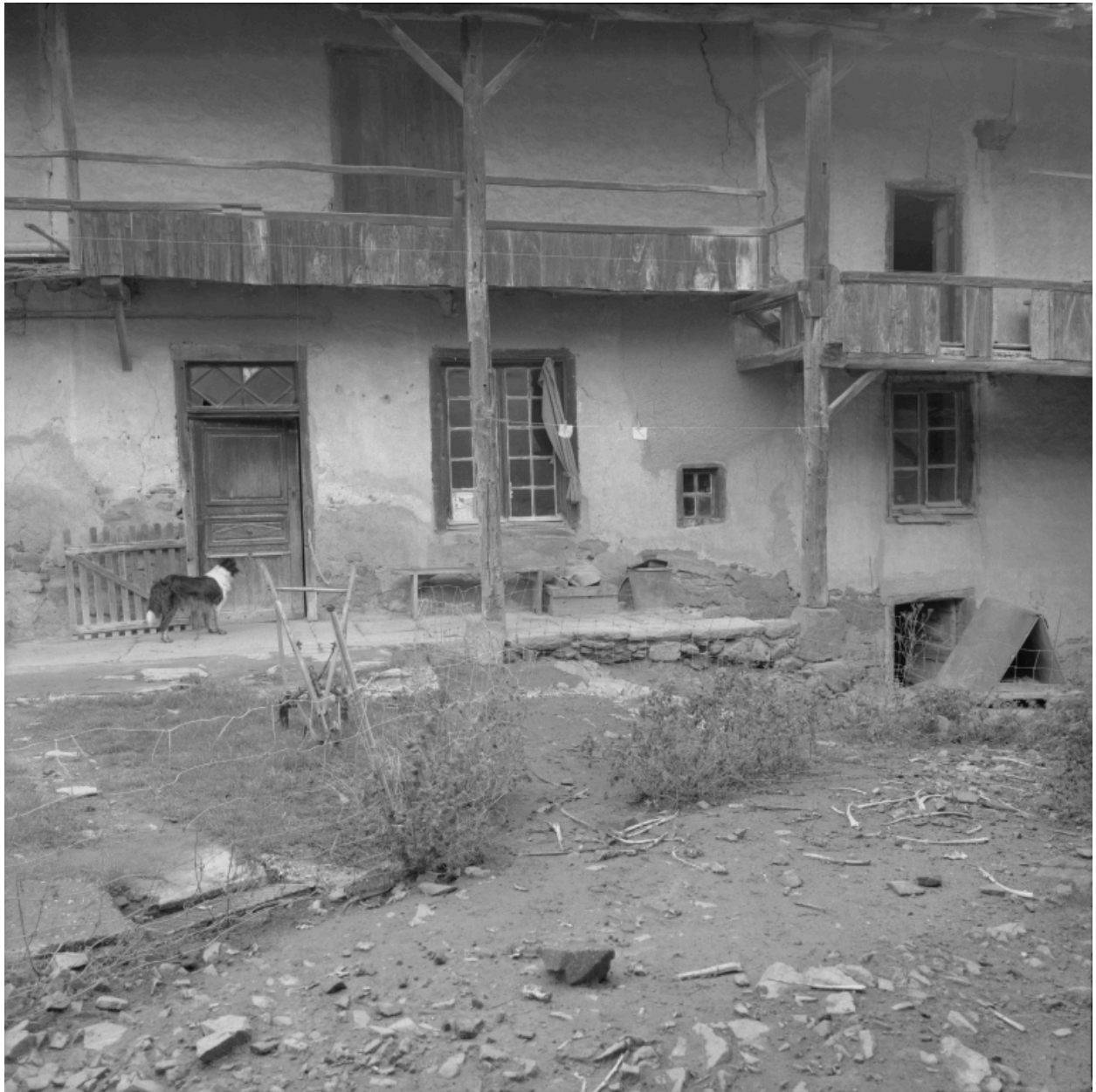
Elévation antérieure du logis, depuis la cour.
