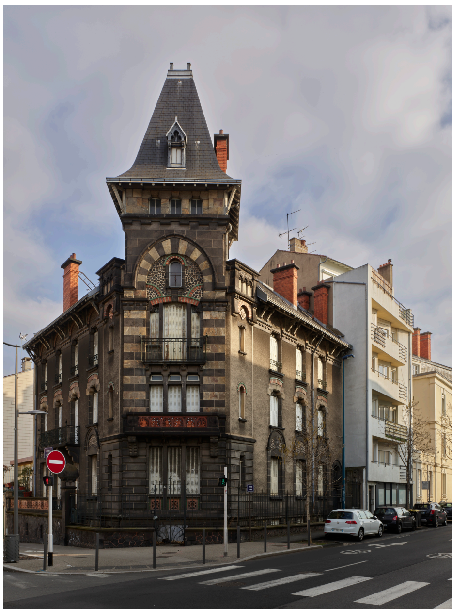
Angle de l'immeuble, dit villa Giraudon, 27 avenue d'Italie
