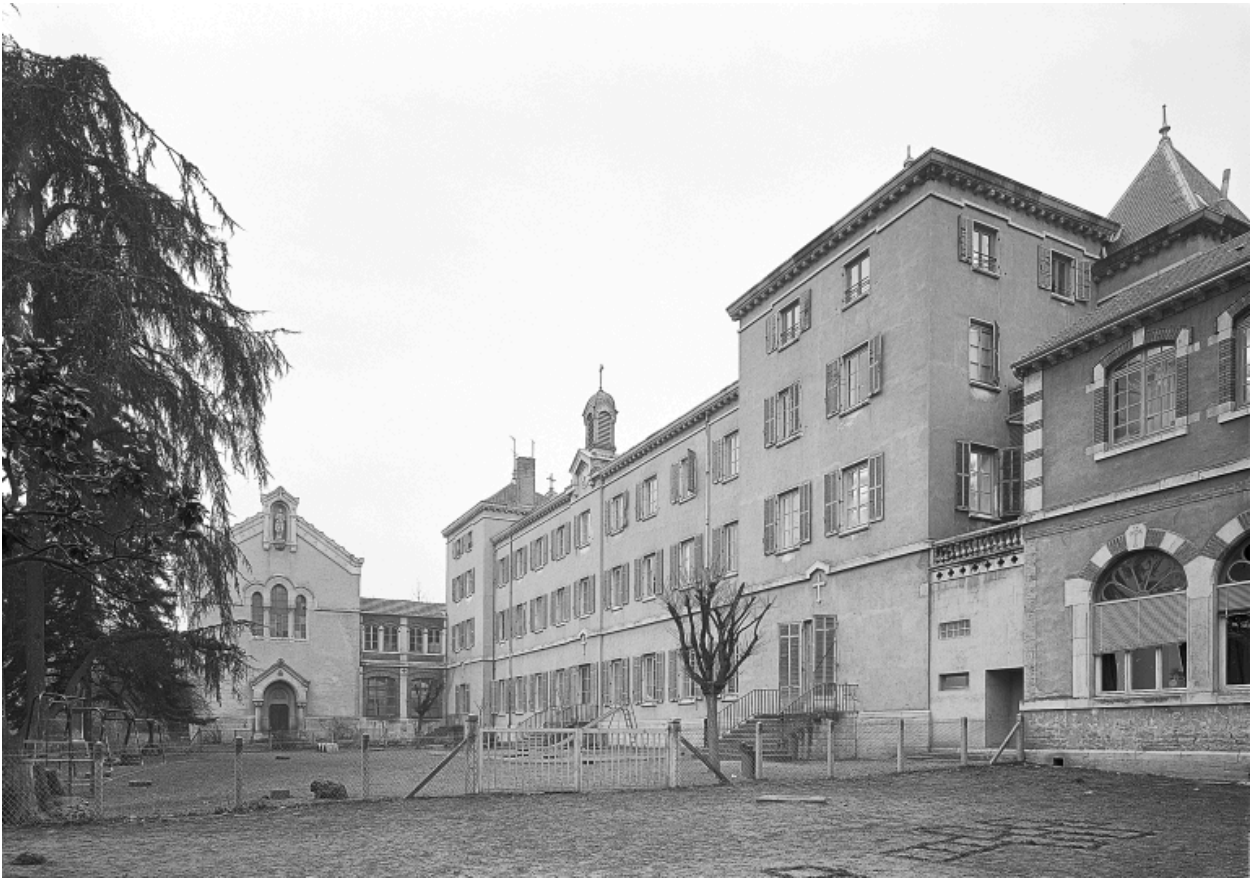
Elévation principale sur jardin.
