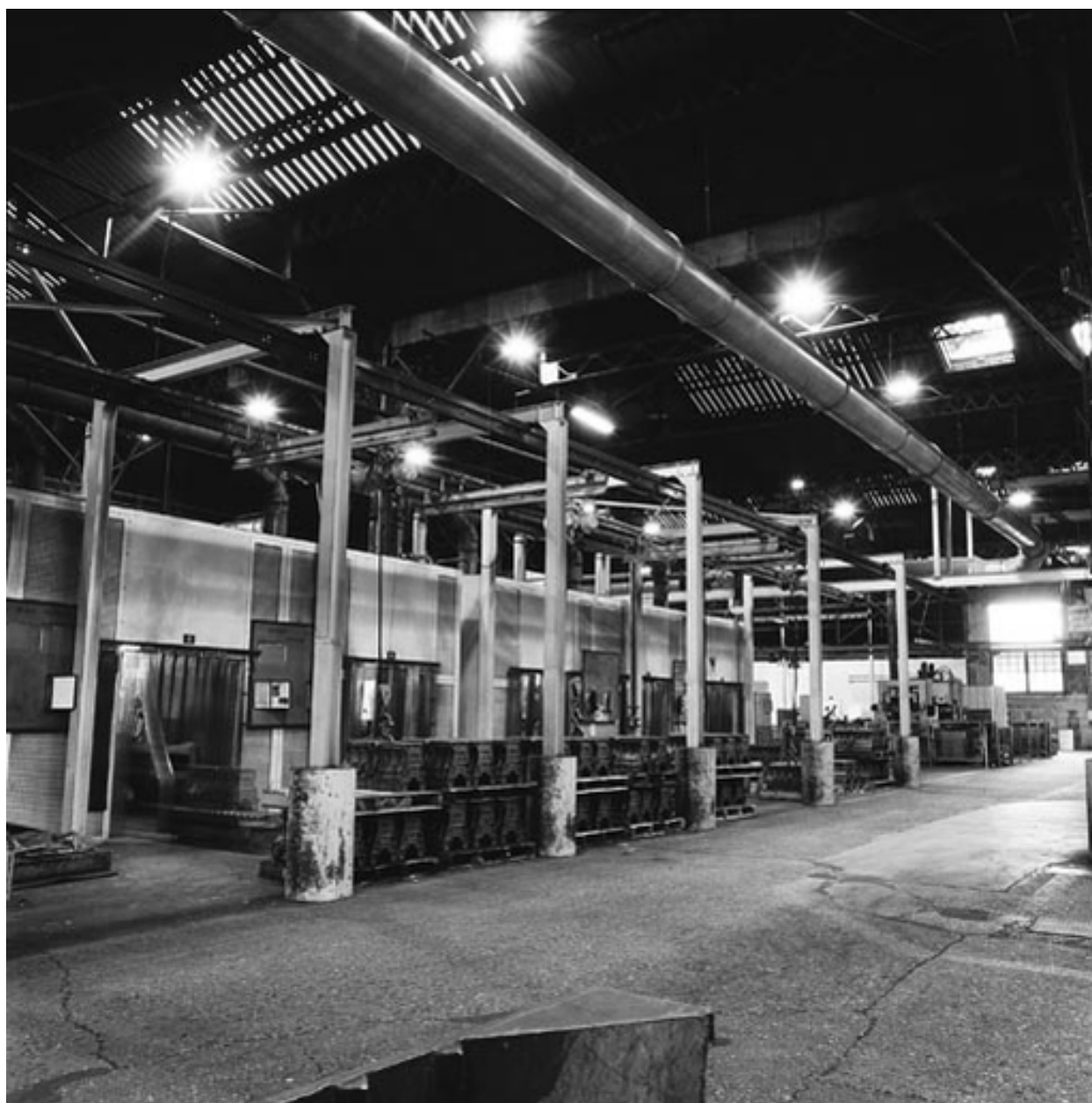
Fonderie : parachèvement sud, vue d'ensemble.
