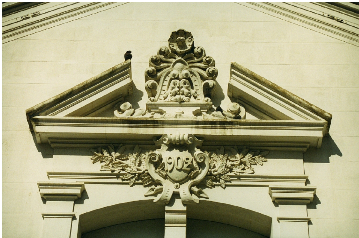
Fronton de la centrale d'énergie
