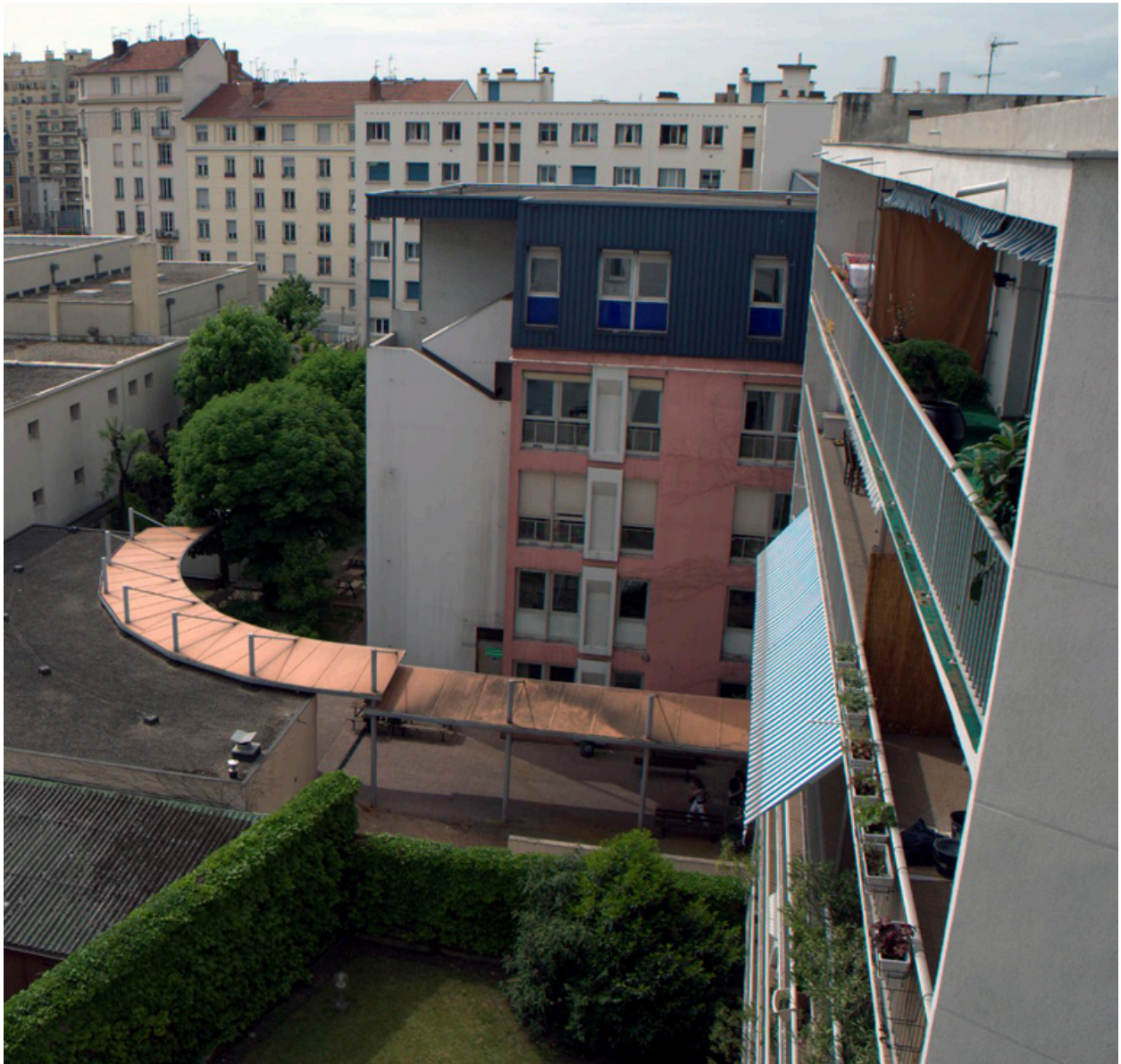
Élévation latérale nord, vue partielle
