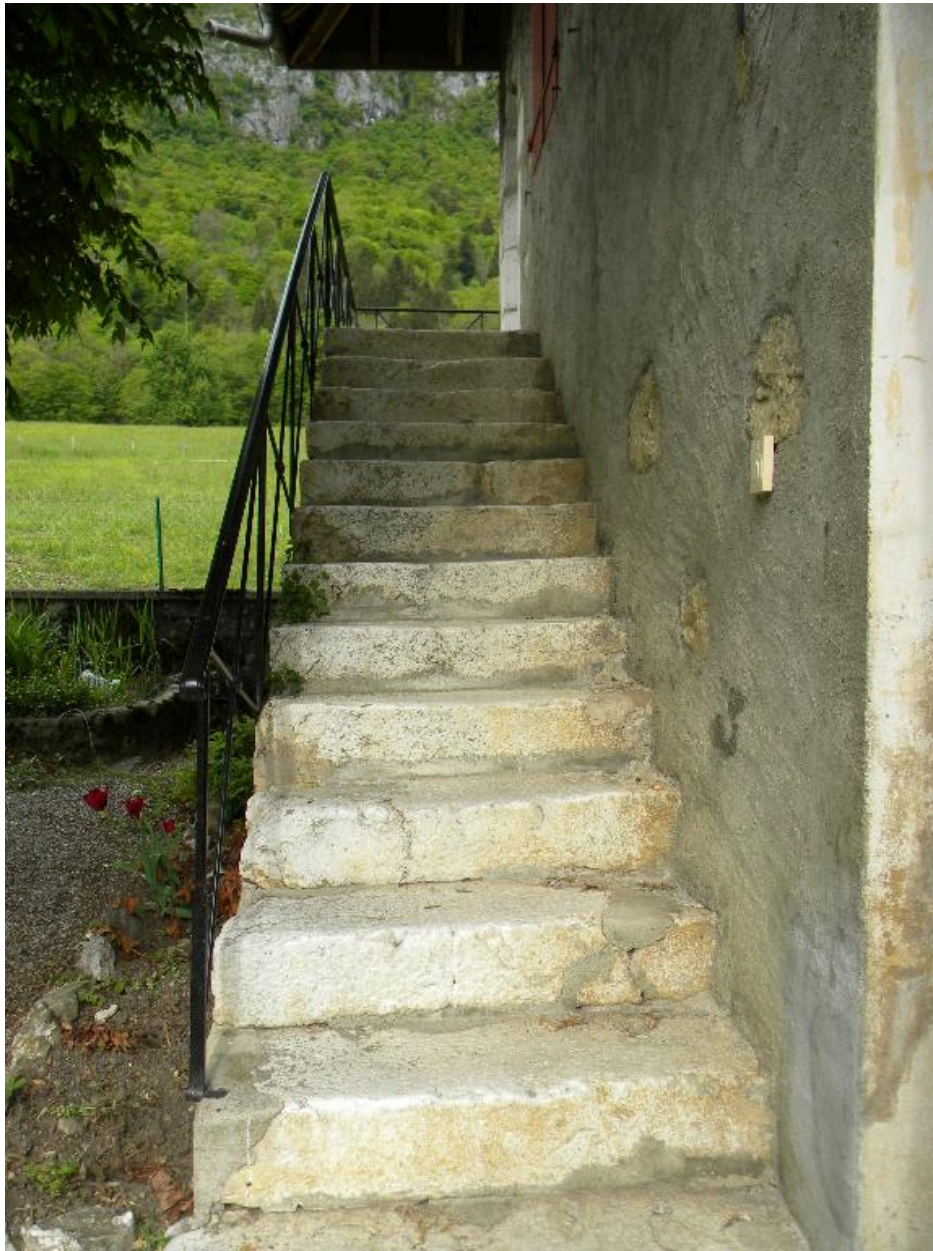
Vue de la montée d'escalier en façade principale.
