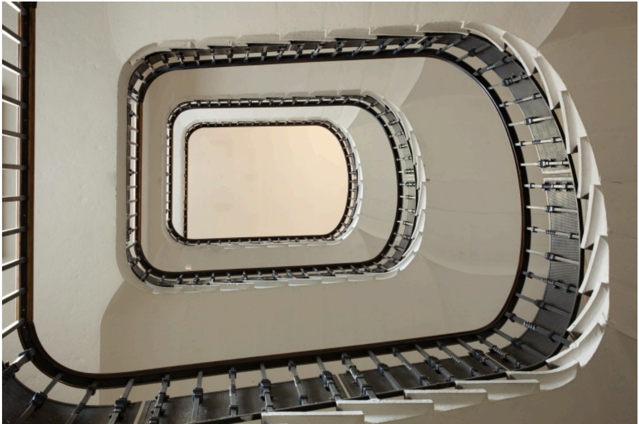
Escalier 1900. Vue en contre-plongée.
