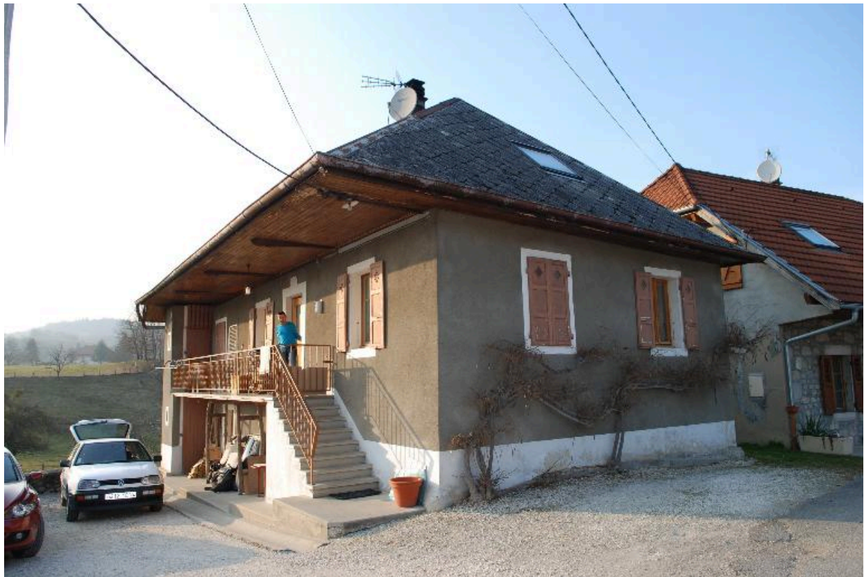
Vue d'ensemble de trois-quarts avant droit.
