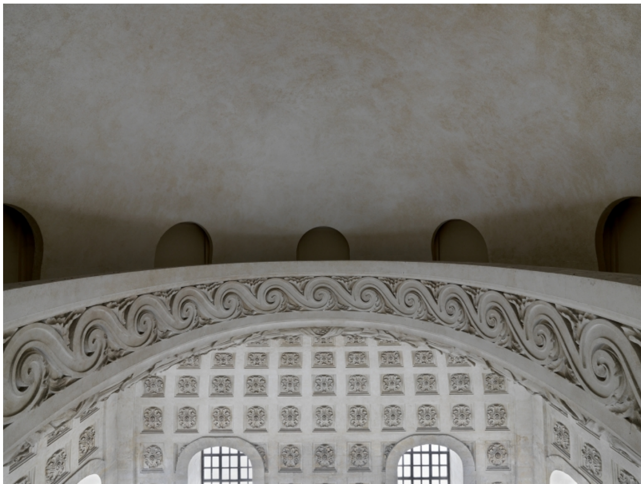
Détail du garde-corps de l'oculus sommital
