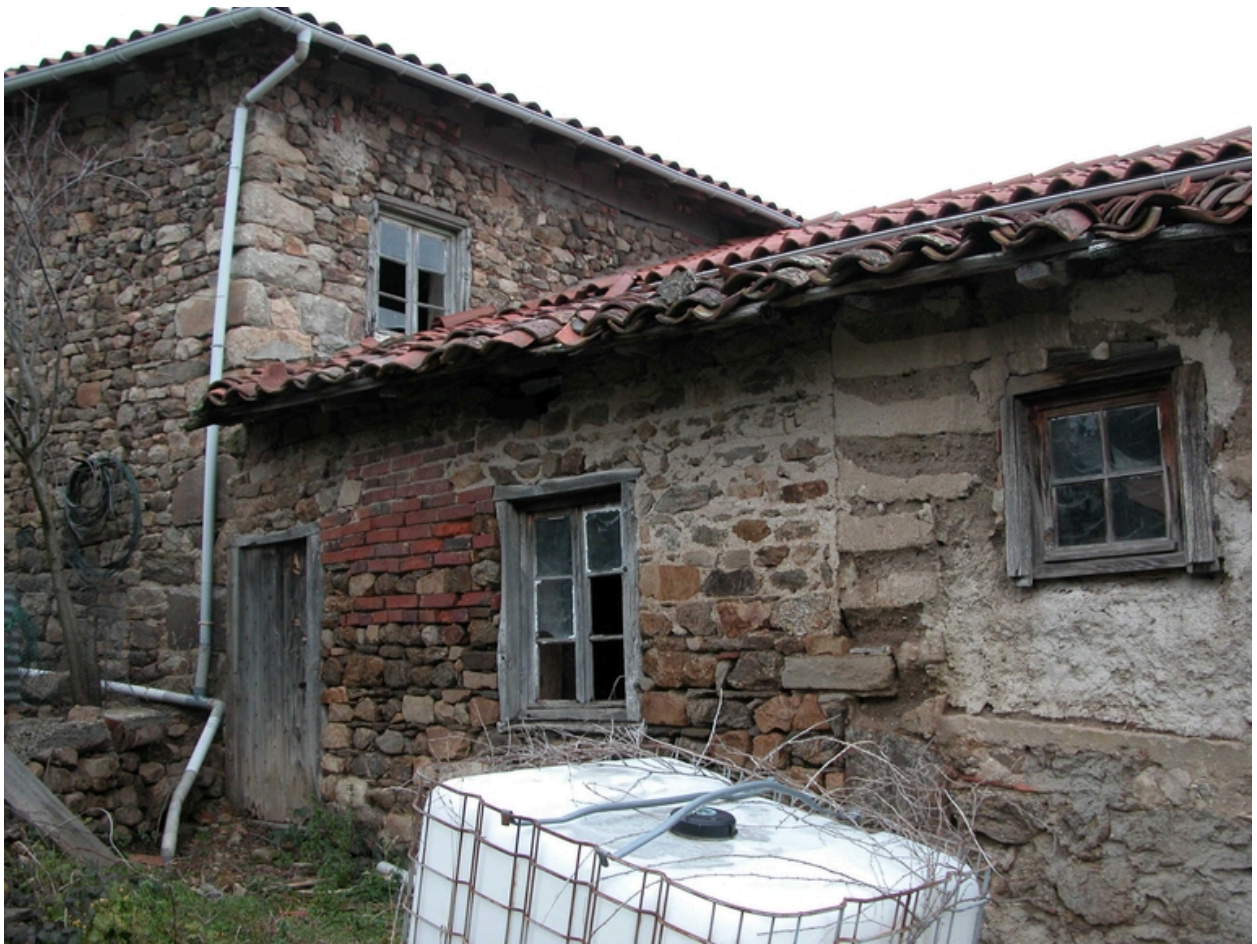
Vue arrière du logis et de la grange-étable, depuis le nord-est : angle du logis, porte et fenêtres des deux chambres prises dans la grange-étable.
