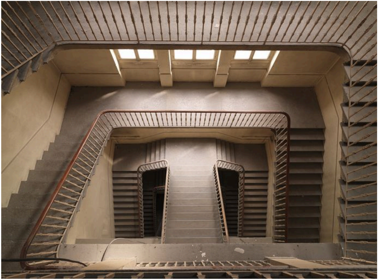
Vue en surplomb de la cage d'escalier.
