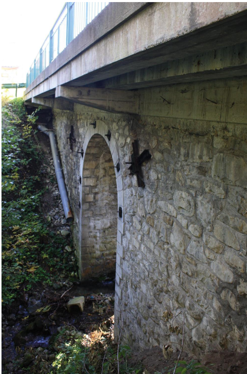
Pont d'Essert-Romand, face aval
