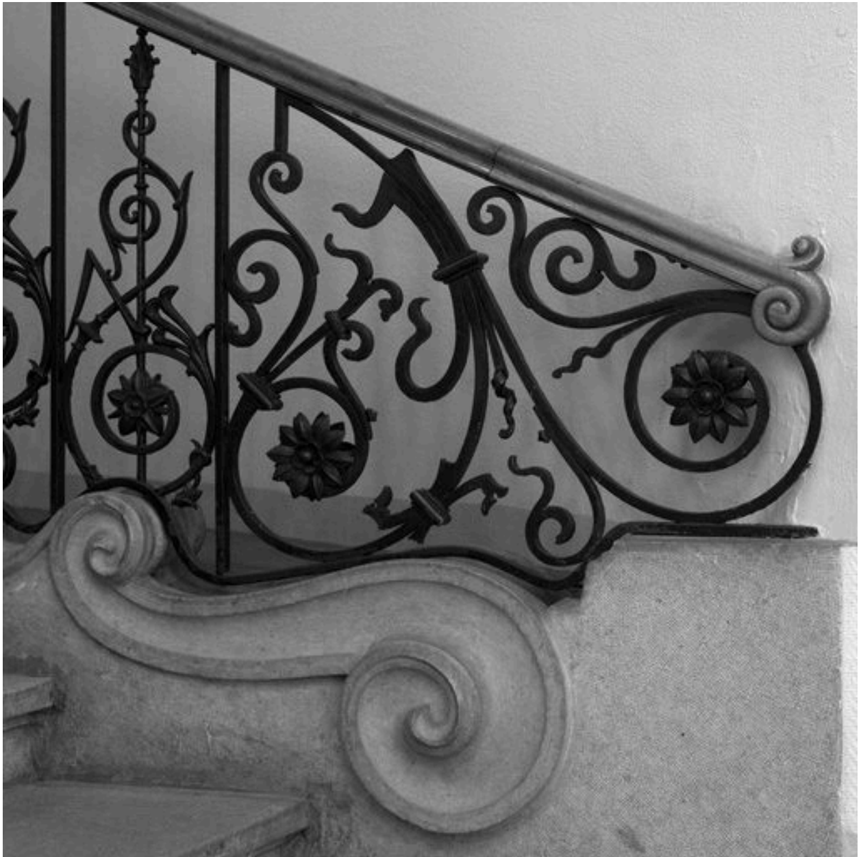
L'escalier : détail du départ
