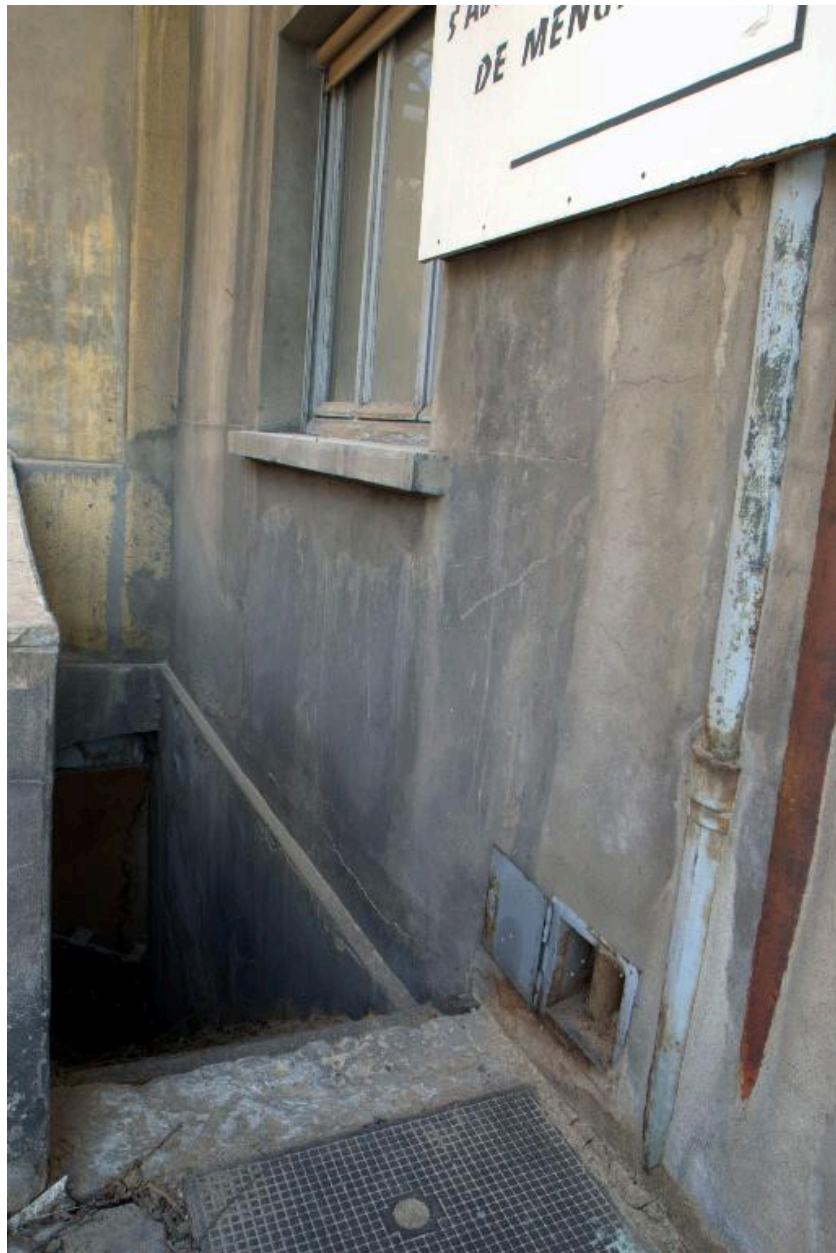
Escalier extérieur conduisant à la mezzanine de l'atelier
