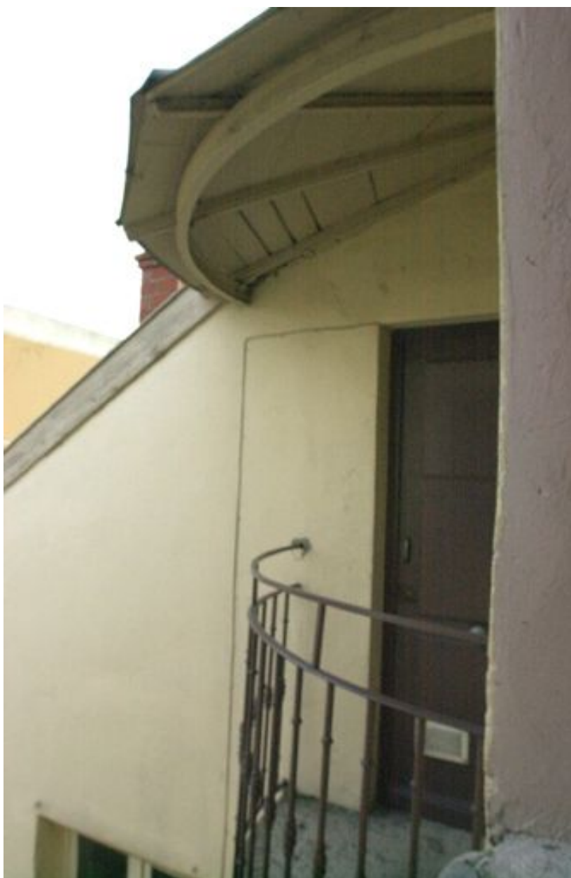
Détail de l'avant-toit au-dessus des balcons
