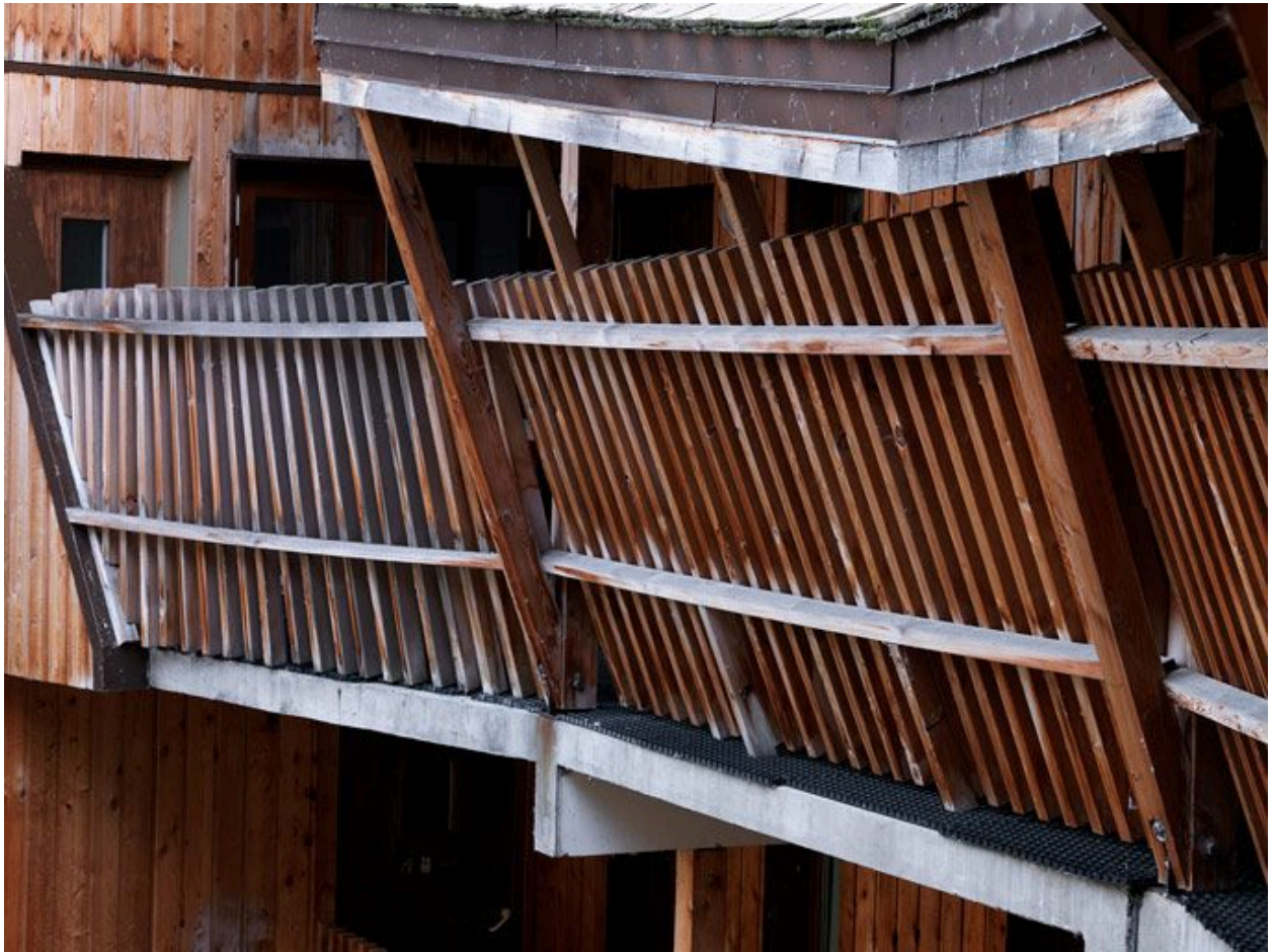
Coursière du 4e étage
