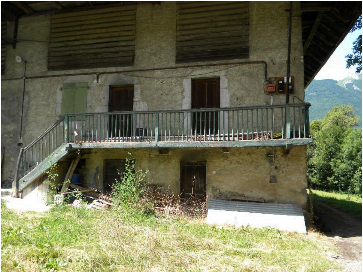
Vue du balcon en façade principale.
