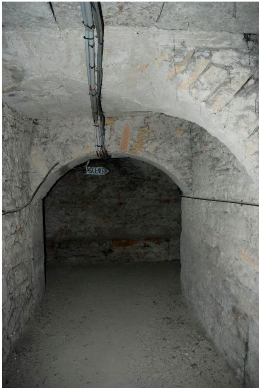
Caves, couloir sous le hall d'accueil
