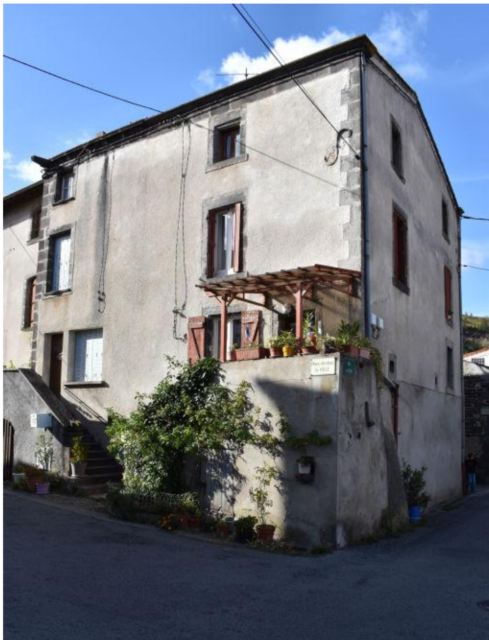
Vue générale : façade
