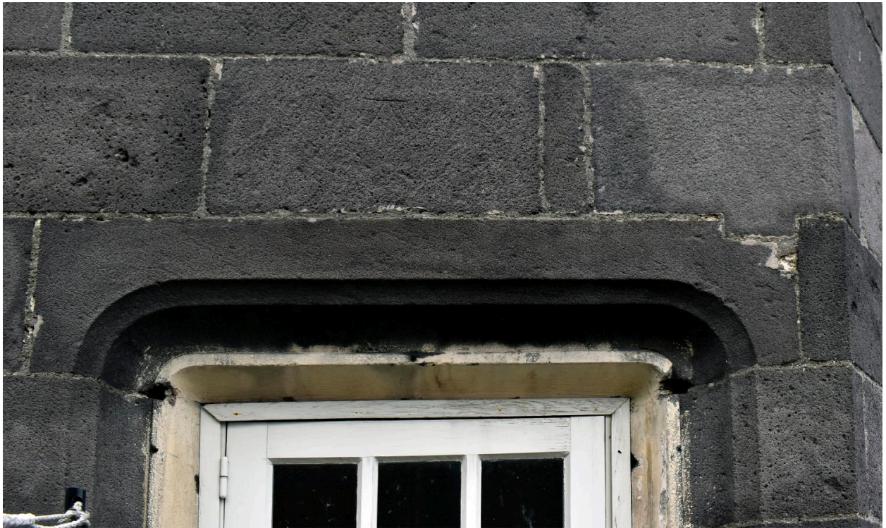
Tour d'escalier : détail du linteau de la baie sommitale
