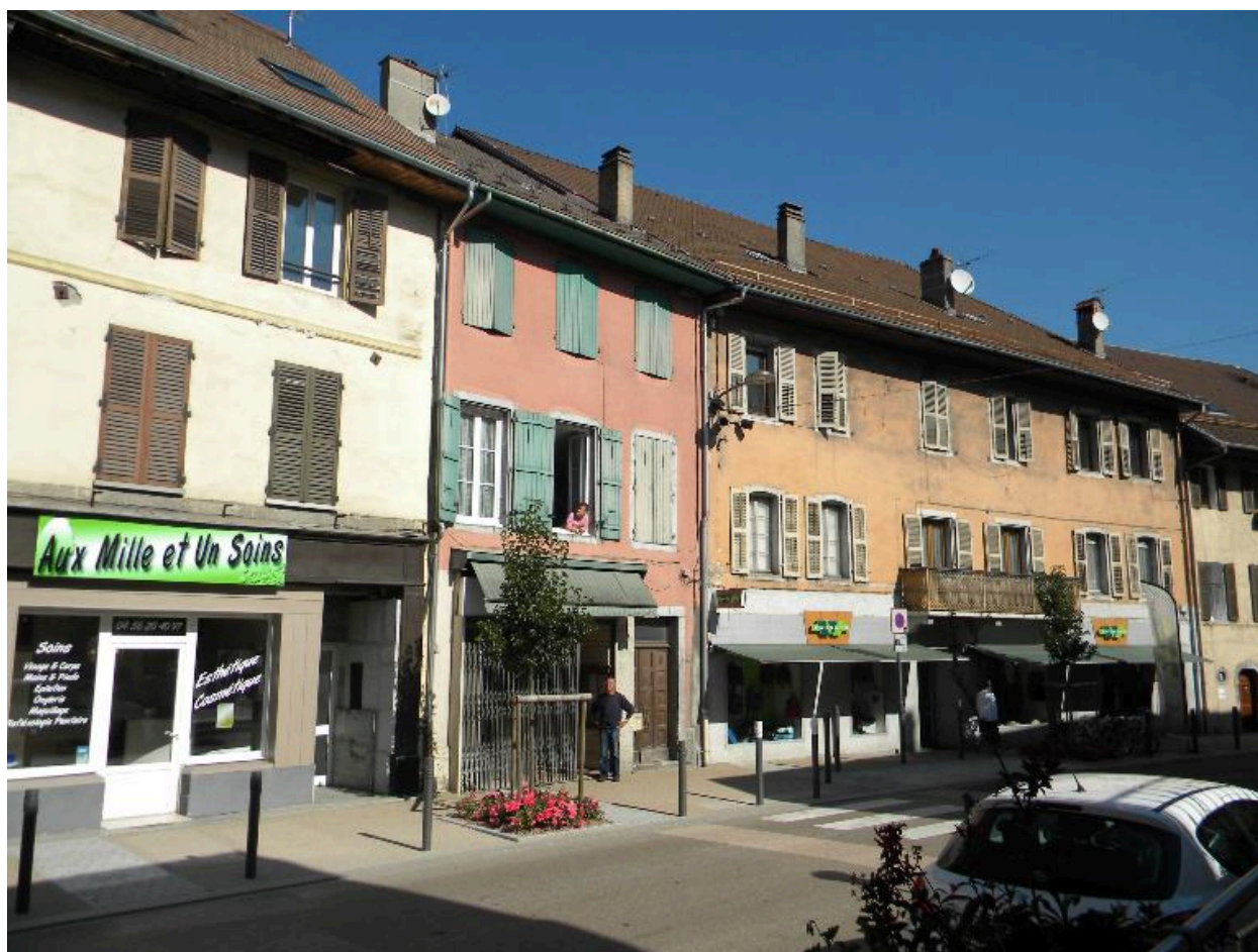
Façades de la rue Sadi Carnot (2008 D15 2373, 3967, 5869).
