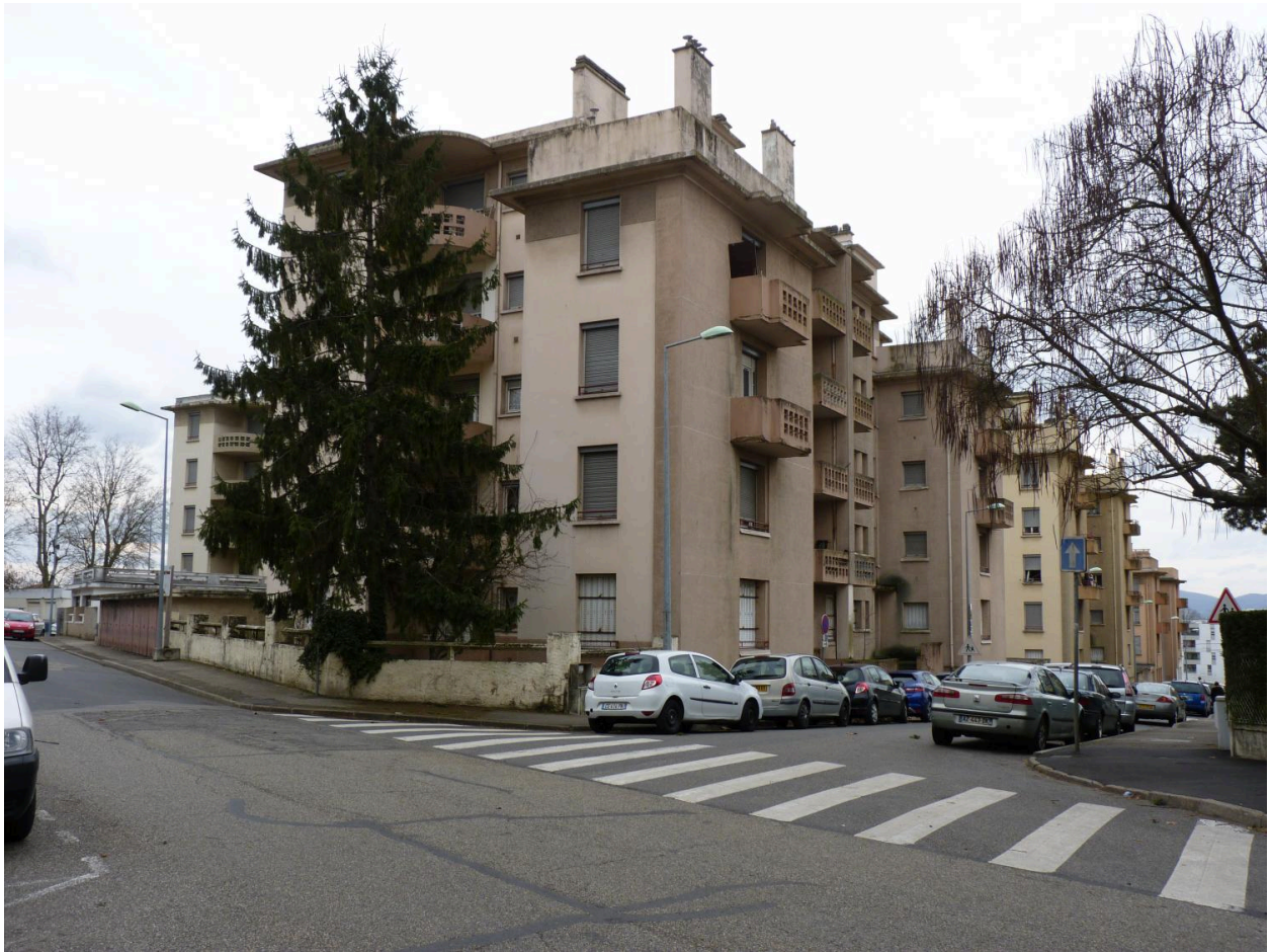
Vue d'ensemble ouest
