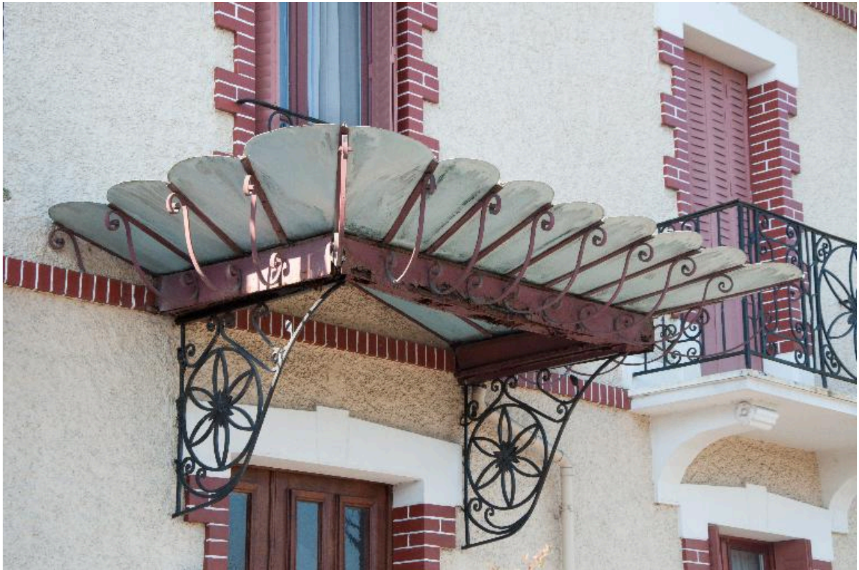
Détail de la marquise
