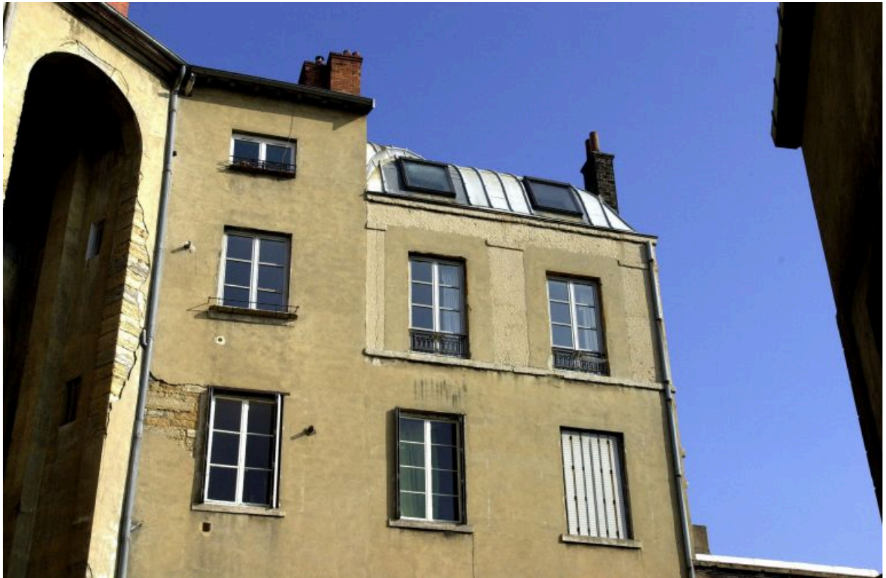
Détail de l'étage de comble sur cour (aile nord-est de l'immeuble)
