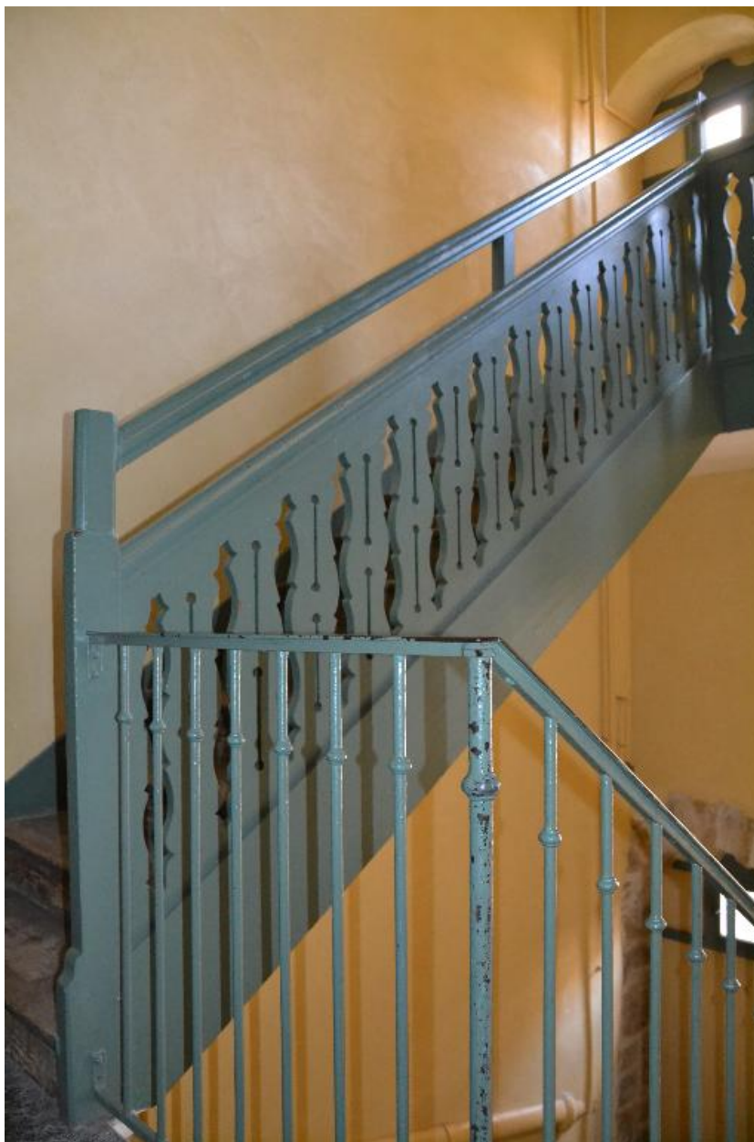
Escalier second niveau
