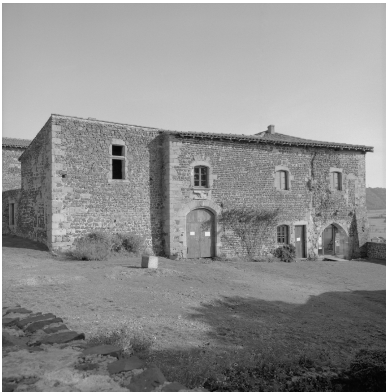
Vue partielle des anciens bâtiments conventuels, façade ouest.
