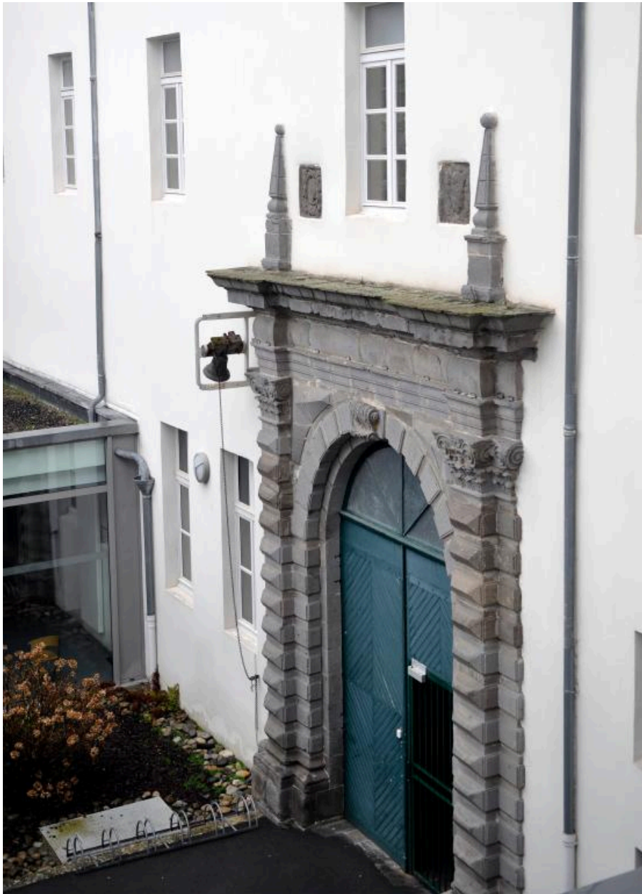
Porte sur cour, vue de trois-quart
