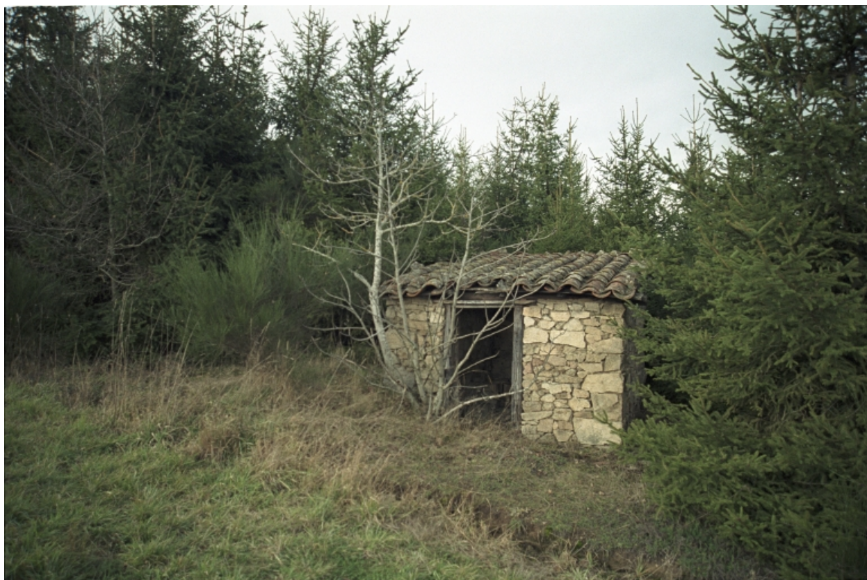
Saint-Sixte, Au Chapey (1987 A2 374). Loge en rez-de-chaussée de type R2b1. Vue d'ensemble.
