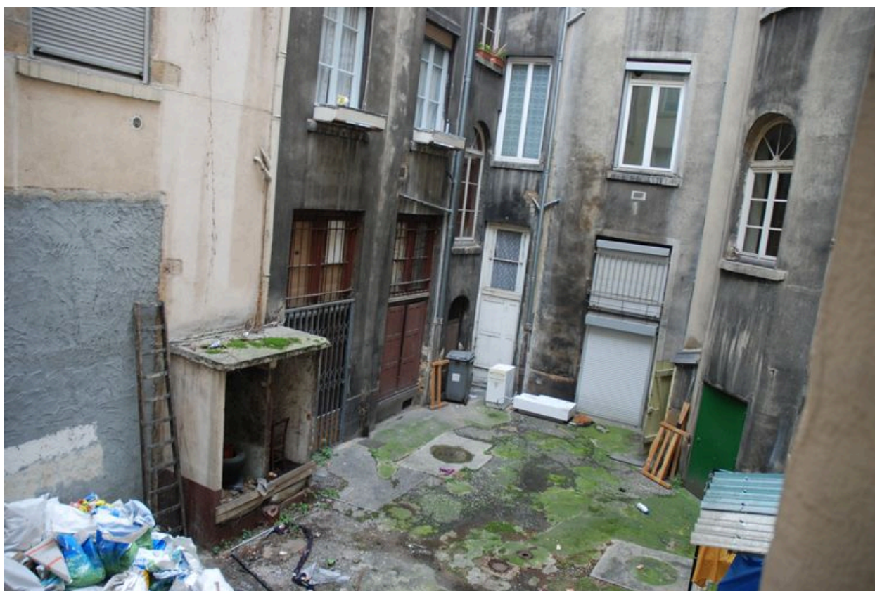
Vue de la cour commune
