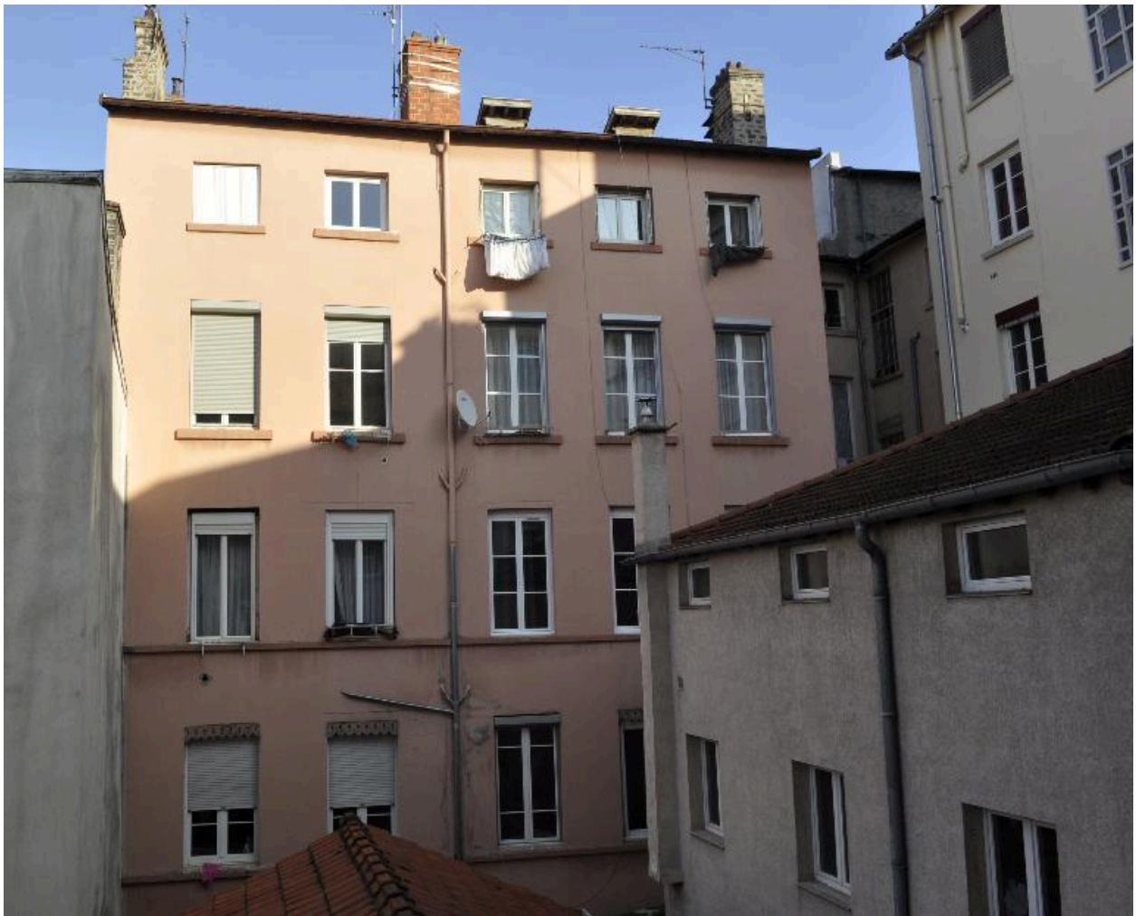
Vue générale de l'élévation postérieure
