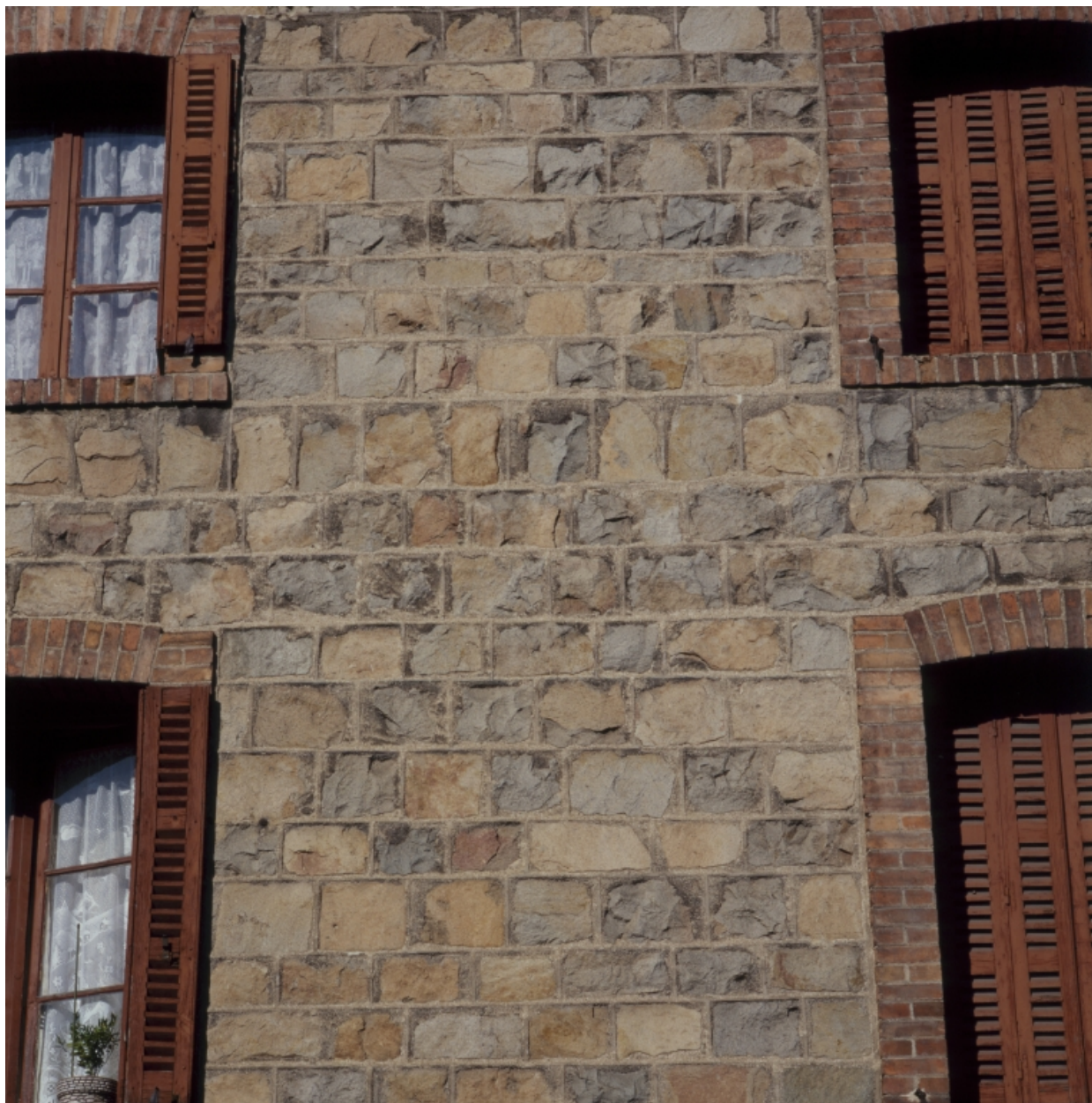
Maison 87, rue de Lyon : mise en oeuvre des murs en moellons assisés de "pierre bleue".
