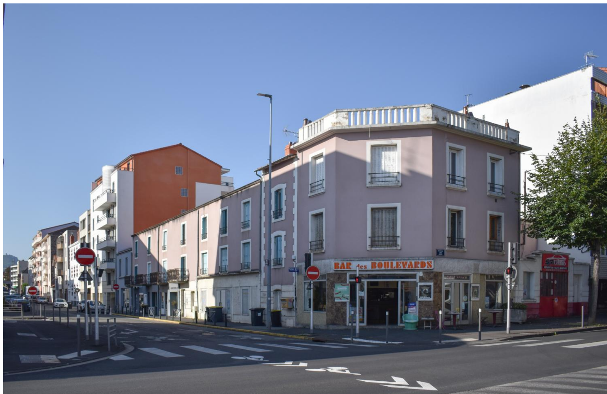
Façade d'angle du boulevard
