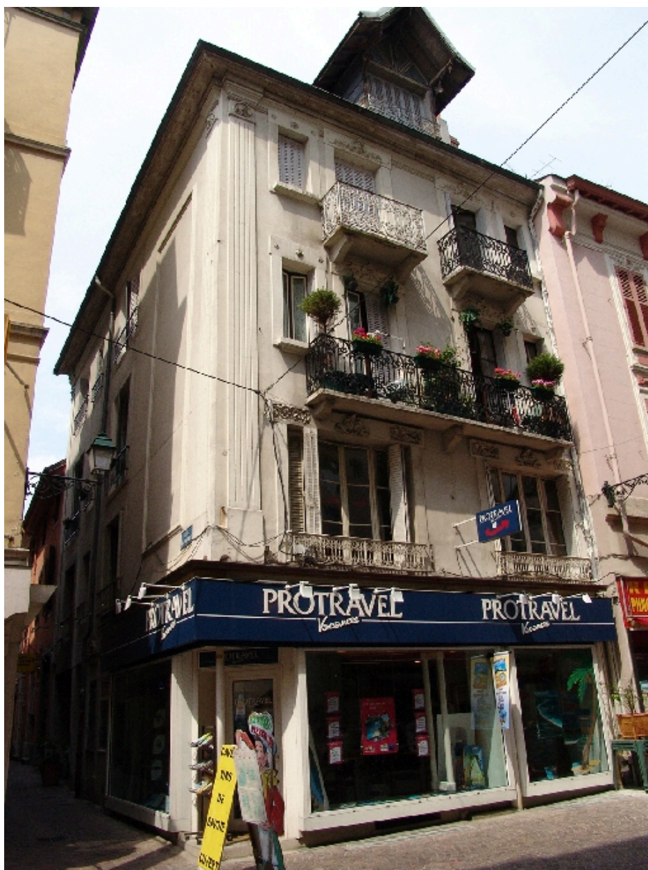
Façade sur la rue des Bains
