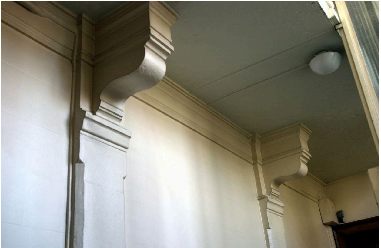
Escalier, détail des consoles portant le palier du 5e étage
