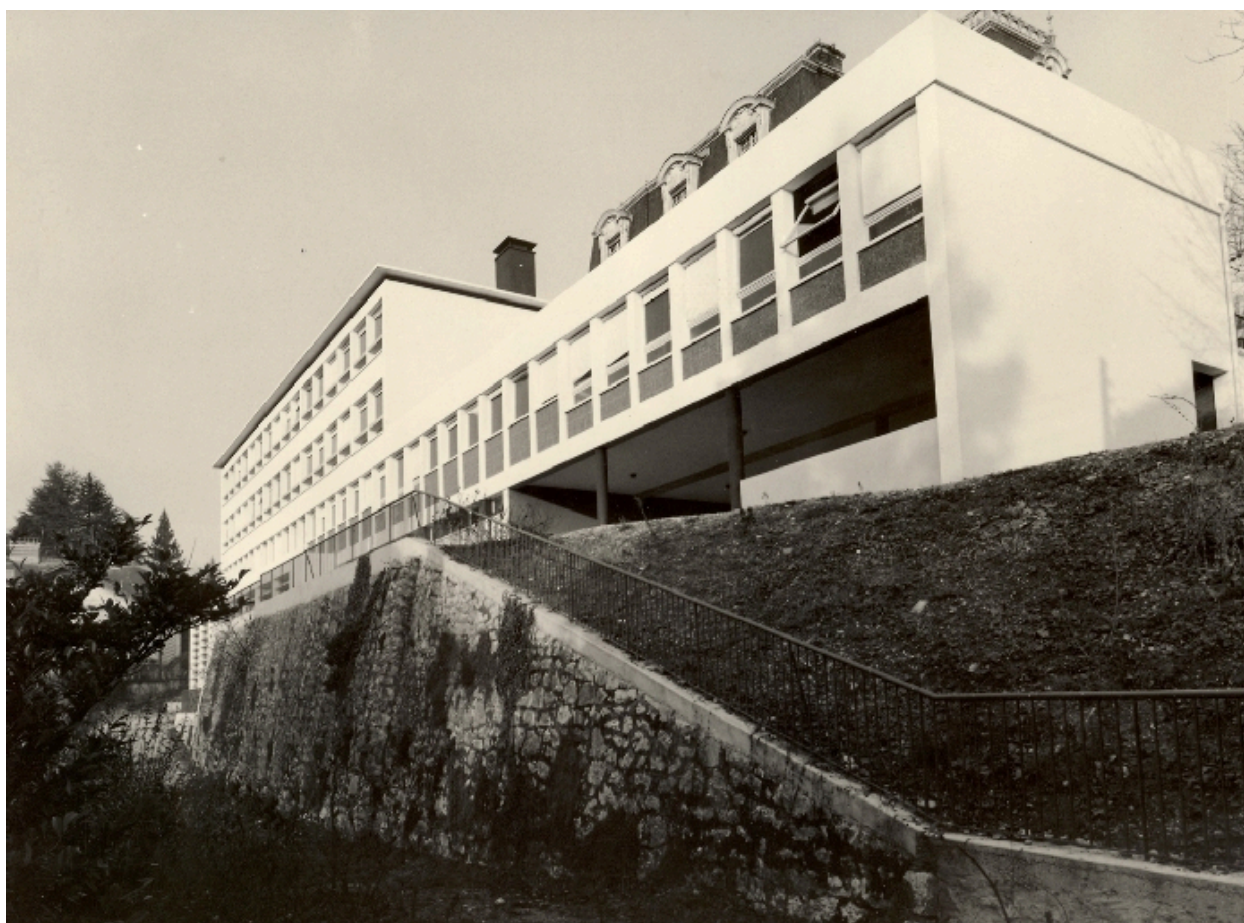
Bâtiment de 1962 : vue d'ensemble prise du sud-ouest
