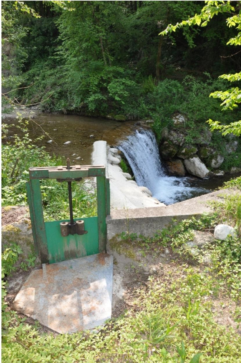
Vue détaillée du barrage avec le système de vannes.
