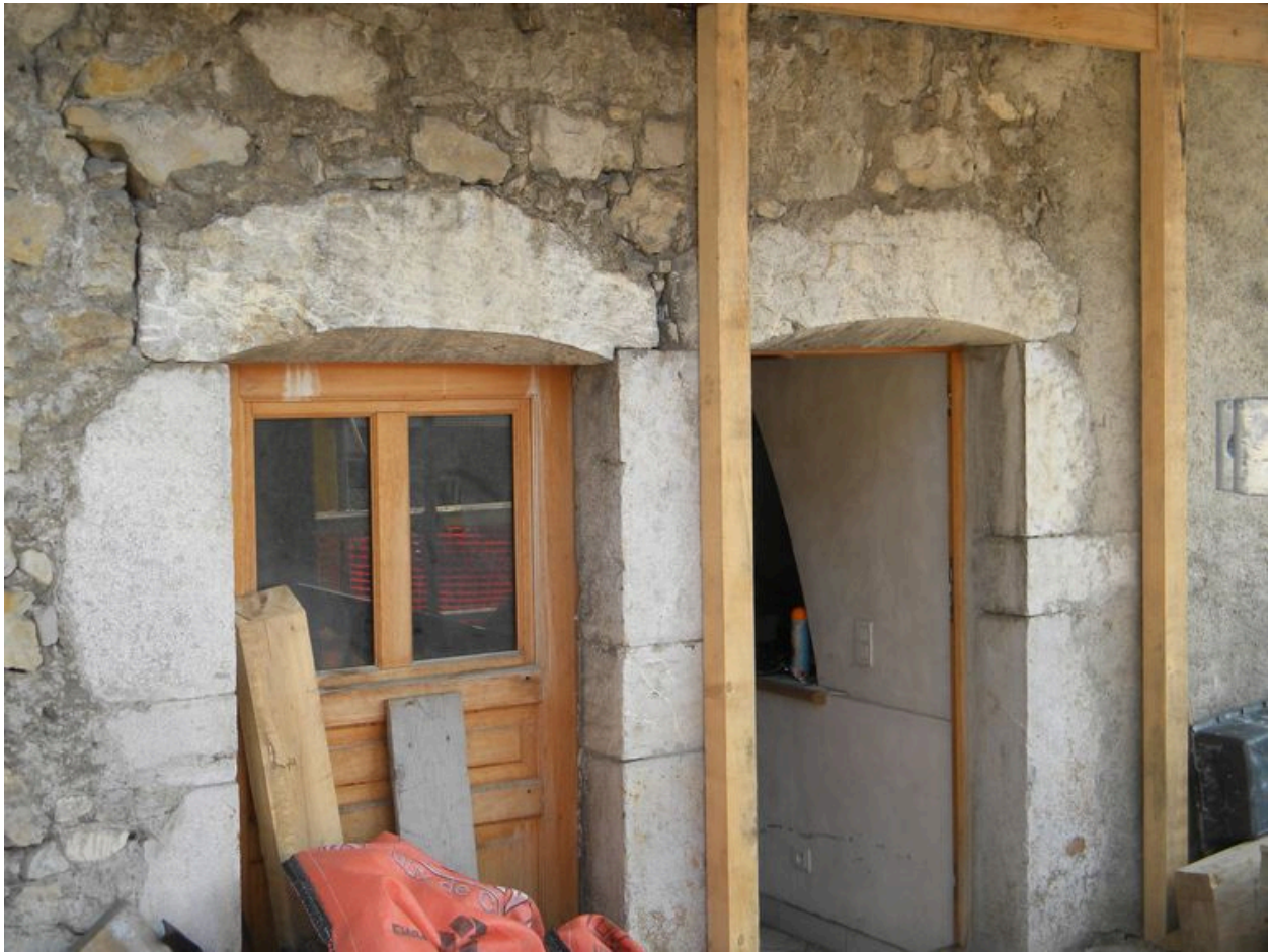
Portes jumelles avec linteaux délardés sur d'anciens celliers accolés (B7 1342, 2 083)
