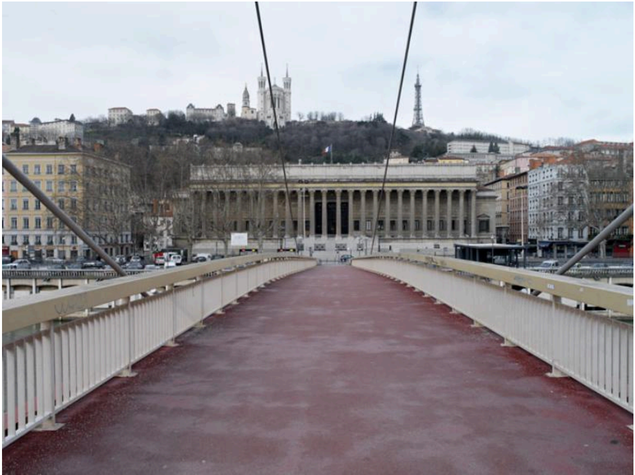
Vue de situation depuis la passerelle du Palais de Justice
