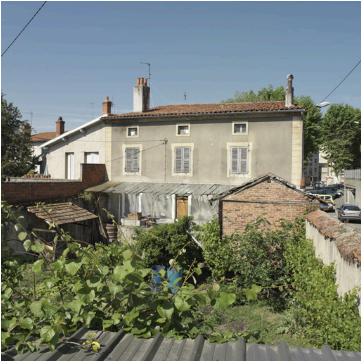
Vue d'ensemble depuis le jardin.
