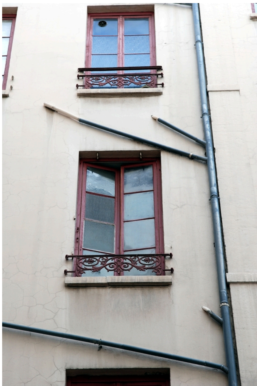
Elévation sur cour : garde-corps
