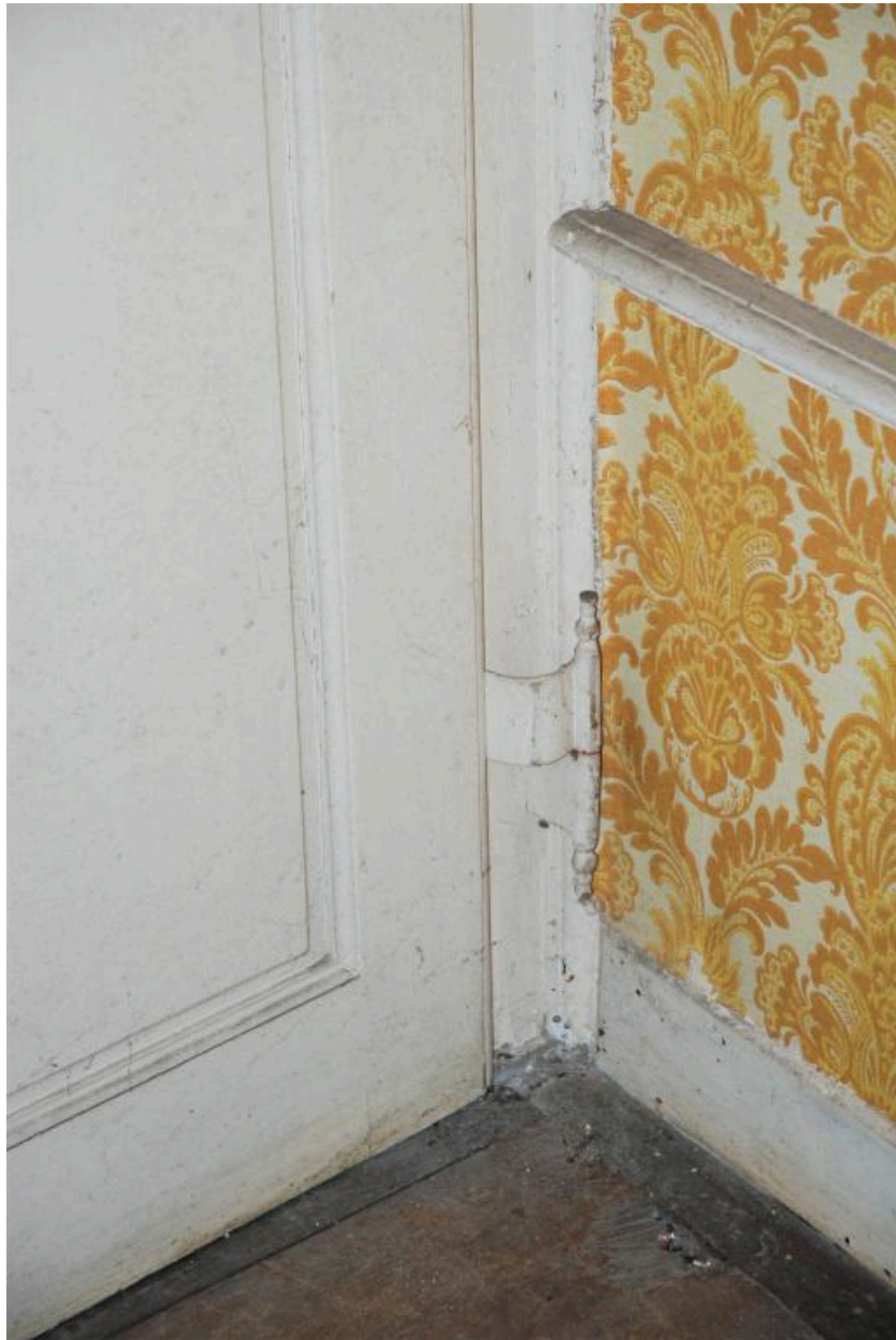
Corps principal, rez-de-chaussée, partie nord, salon (Cf. Plan RDC 2), porte de placard nord, détail gond en partie basse.
