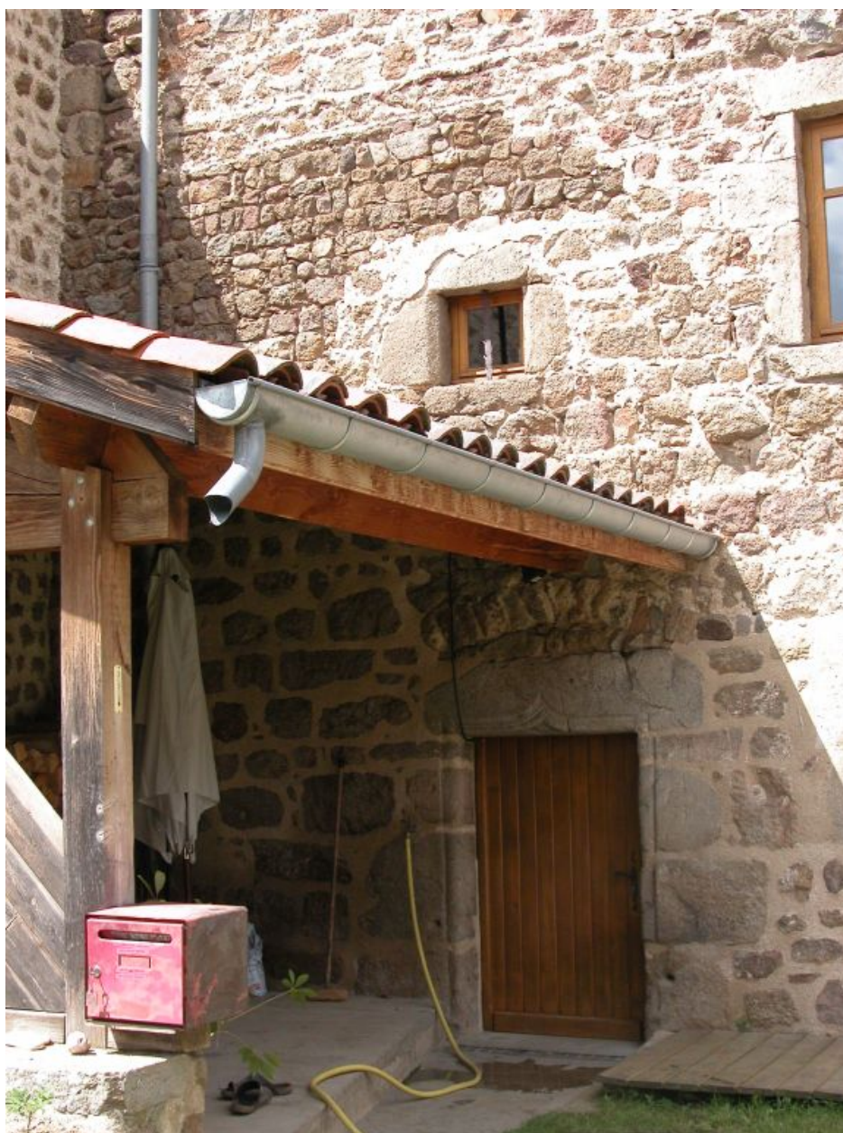
Détail de la partie droite et ancienne du logis.
