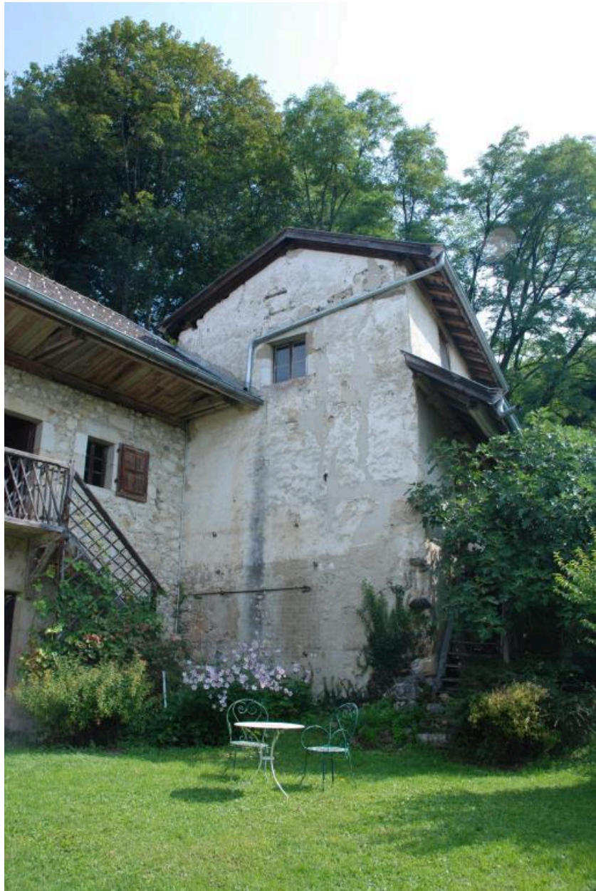
Vue d'ensemble de la façade ouest du bâtiment dit la Pigeonnière.
