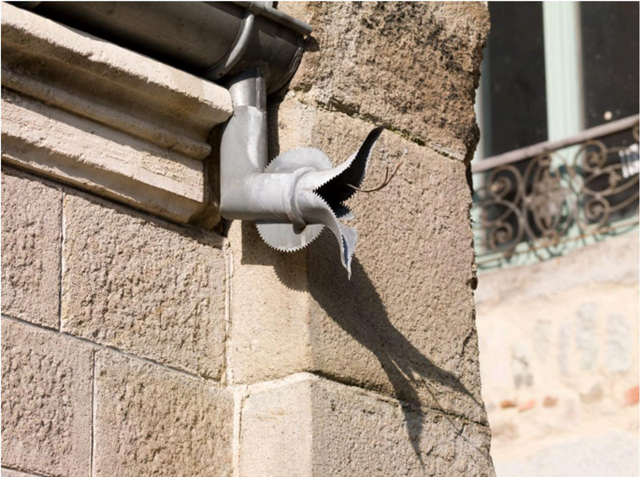
Détail, conduit d'évacuation des eaux terminé par une gargouille saillante en forme de figure fantastique
