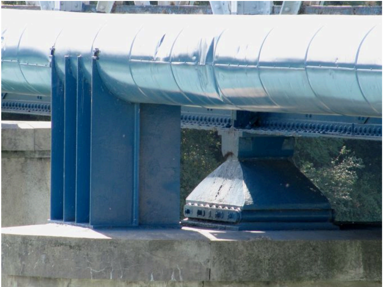
Tablier, face amont, vue de détail . jonction avec la pile (depuis la rive droite)
