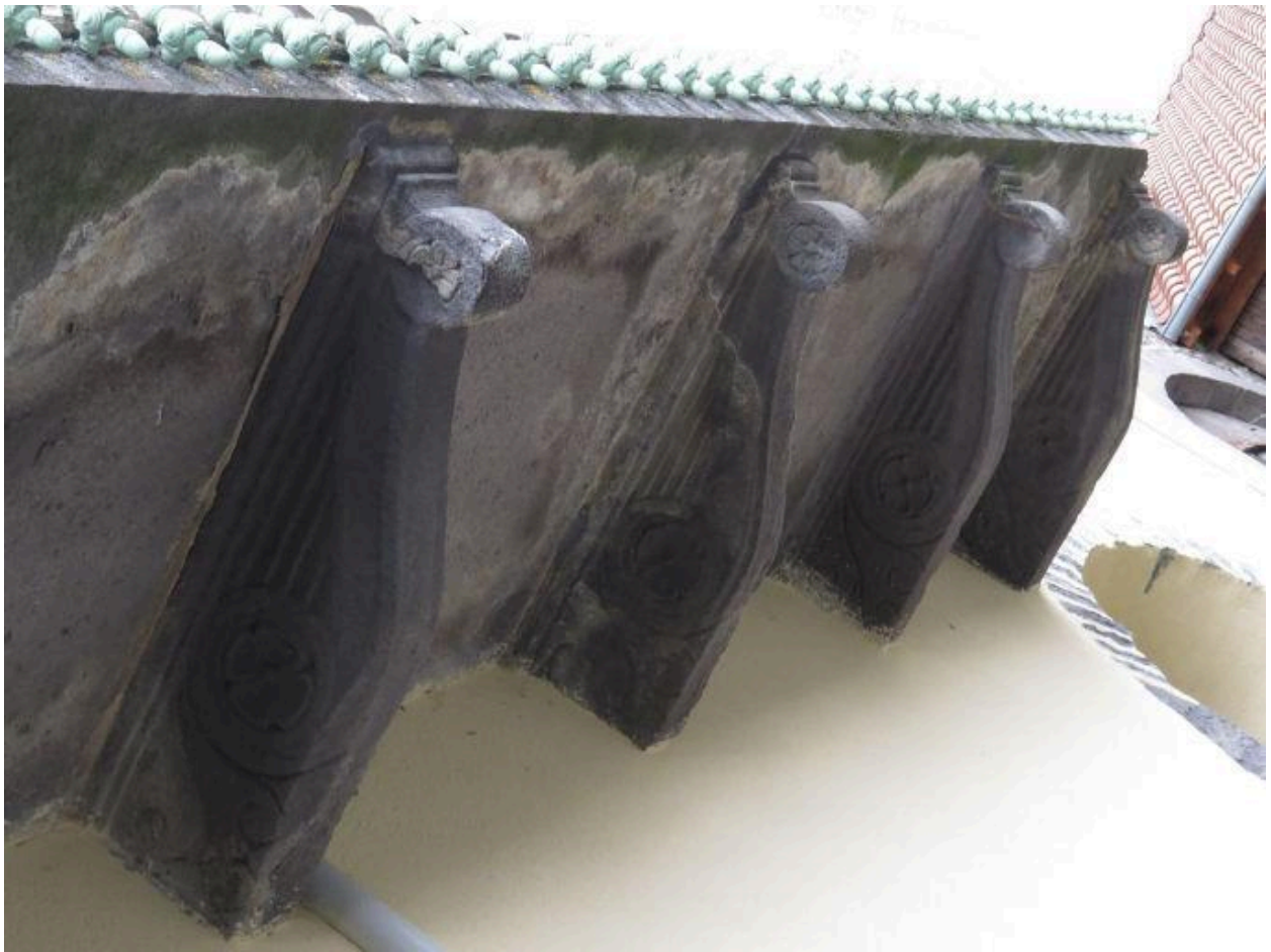
Vue de détail : consoles décorées du palier formant balcon
