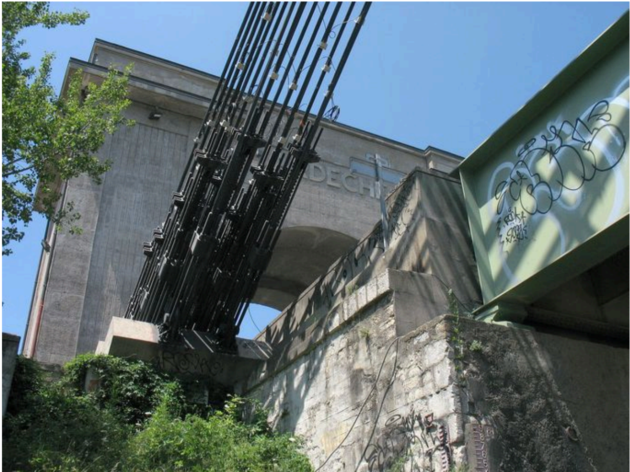
Rive droite : culée, câbles d'ancrage et arc monumental, vue partielle
