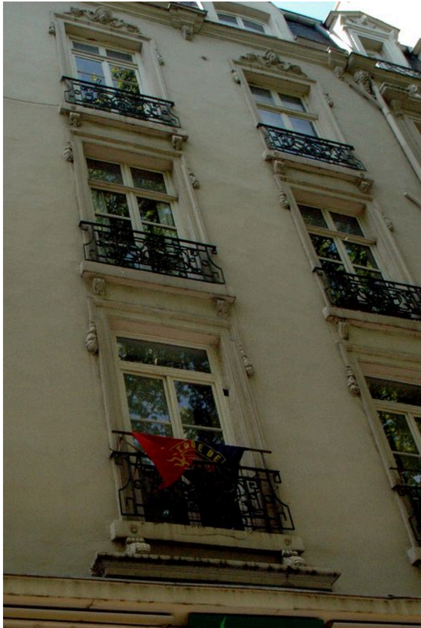
Travée de fenêtres de la partie gauche de l'immeuble
